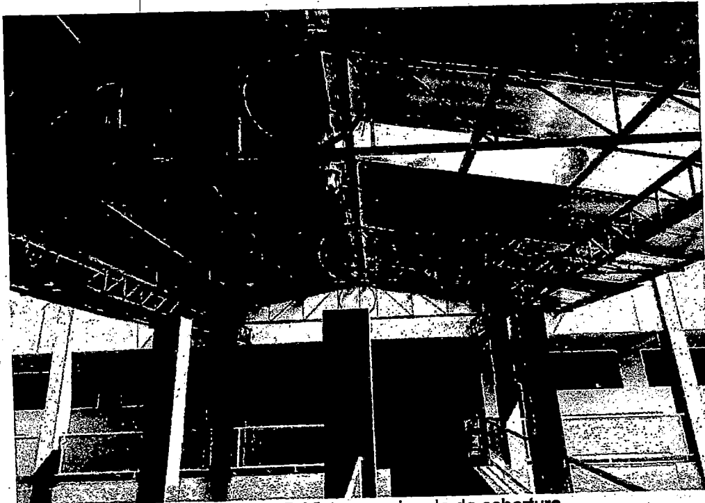
Foto 05: Vista aproximada da cobertura
