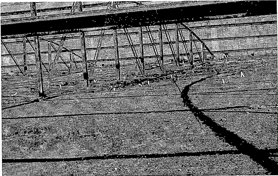
Figura 2: Deformação pontual da laje
