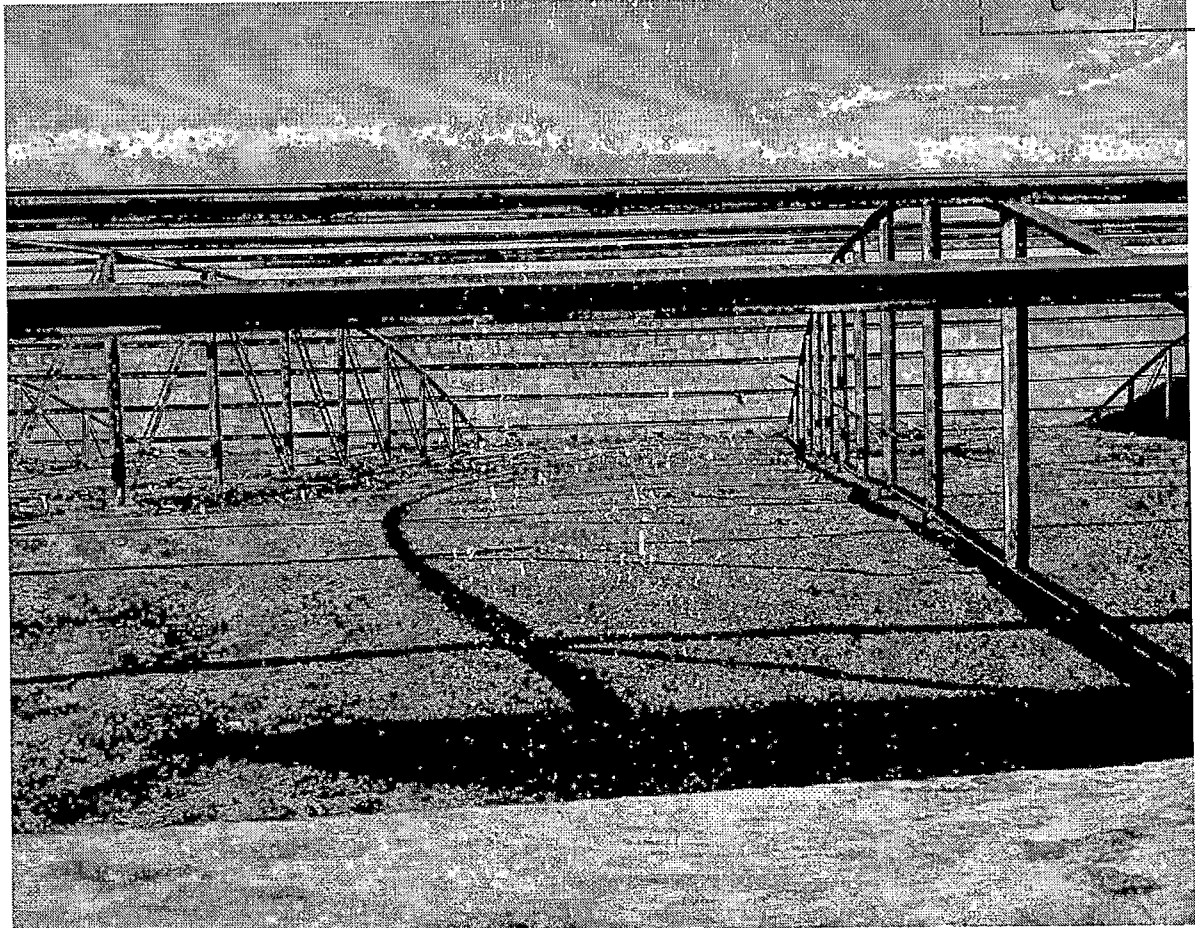
Figura 7: Estrutura metálica com sinais graves de corrosão. Nota-se que a estrutura não foi finalizada pela falta de diagonais na treliça.
