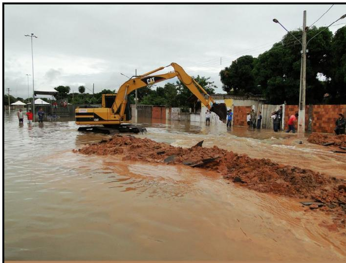
Figura 05 - Abertura da canalização do Córrego Sangradouro para escoamento da água.
