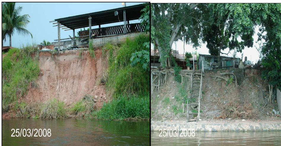
Figura 5: Erosão marginal e muro de arrimo no rio Paraguai.
