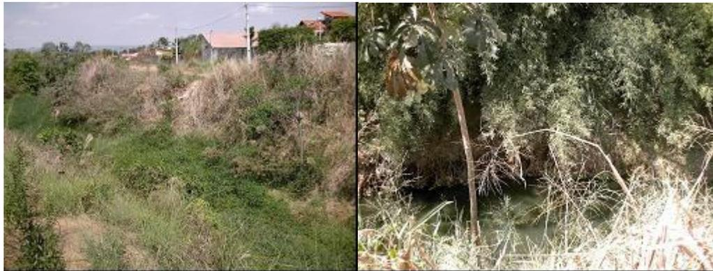
Figura 03 – Degradação do canal, lançamento de esgoto e água empoçada no canal
